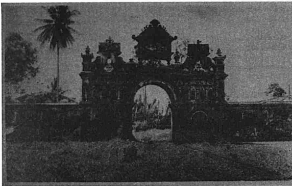
Pintu gerbang Kota Tengah Istana Sultan Abd. Hamid Halim Shah (1882–1943) yang penuh dengan ukiran senibina Melayu lama. Di tapaknya ialah bangunan Wisma Negeri sekarang.
