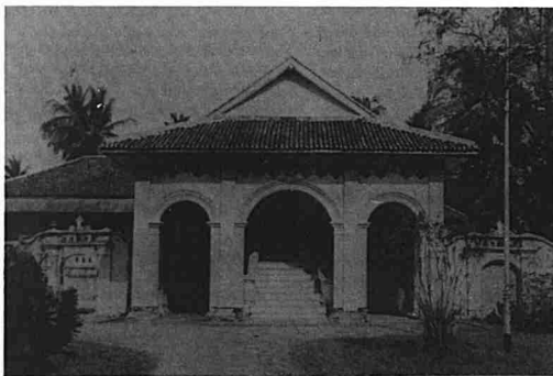
Rumah Pelamin (Arkib Negara Malaysia)
