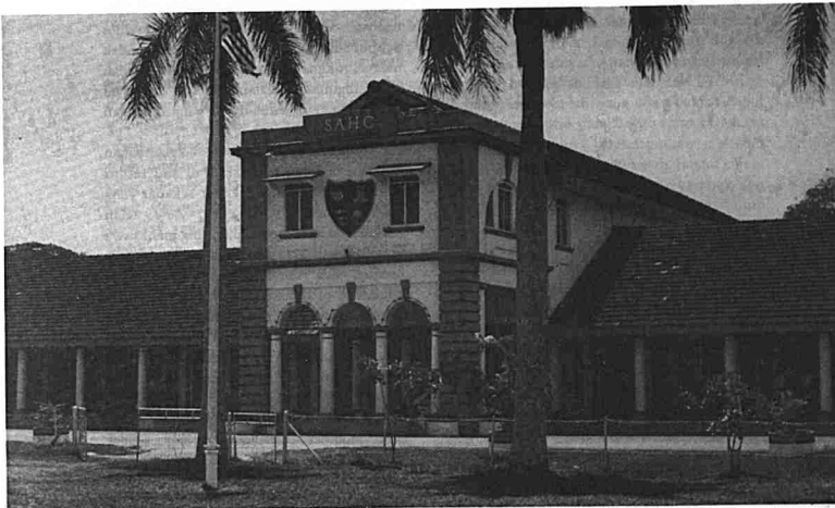
Bangunan Kolej Sultan Abd. Hamid
